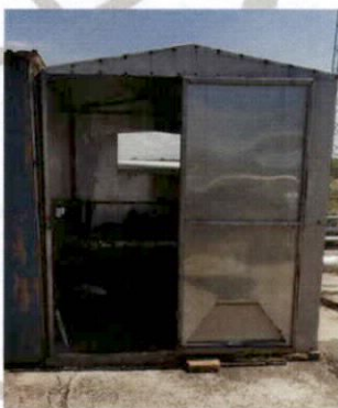
постојећи контејнерски објекат
